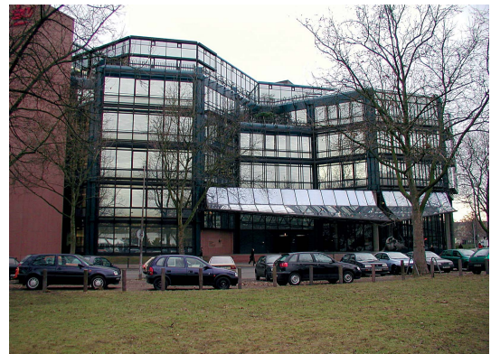
Bild 6: Bürogebäude einer Versicherungsgesellschaft (Quelle: H. Wieland)
